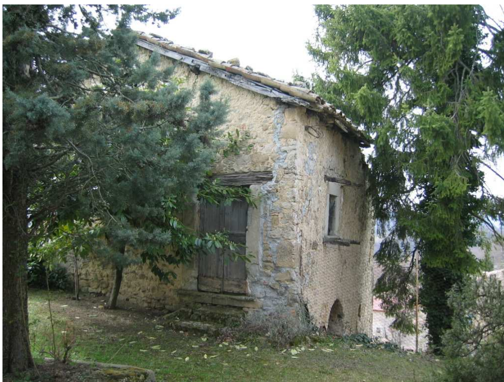
Foto n. 9: Miralago. Edificio rurale del XV sec.
