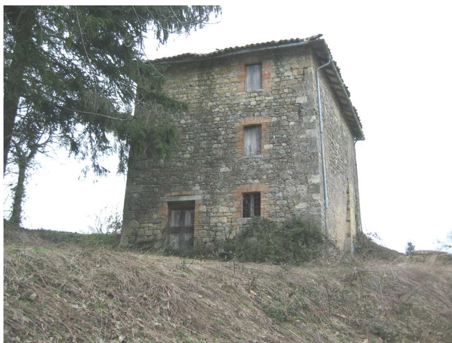
Foto n. 75 Torricella. Edificio in prossimità della torre
