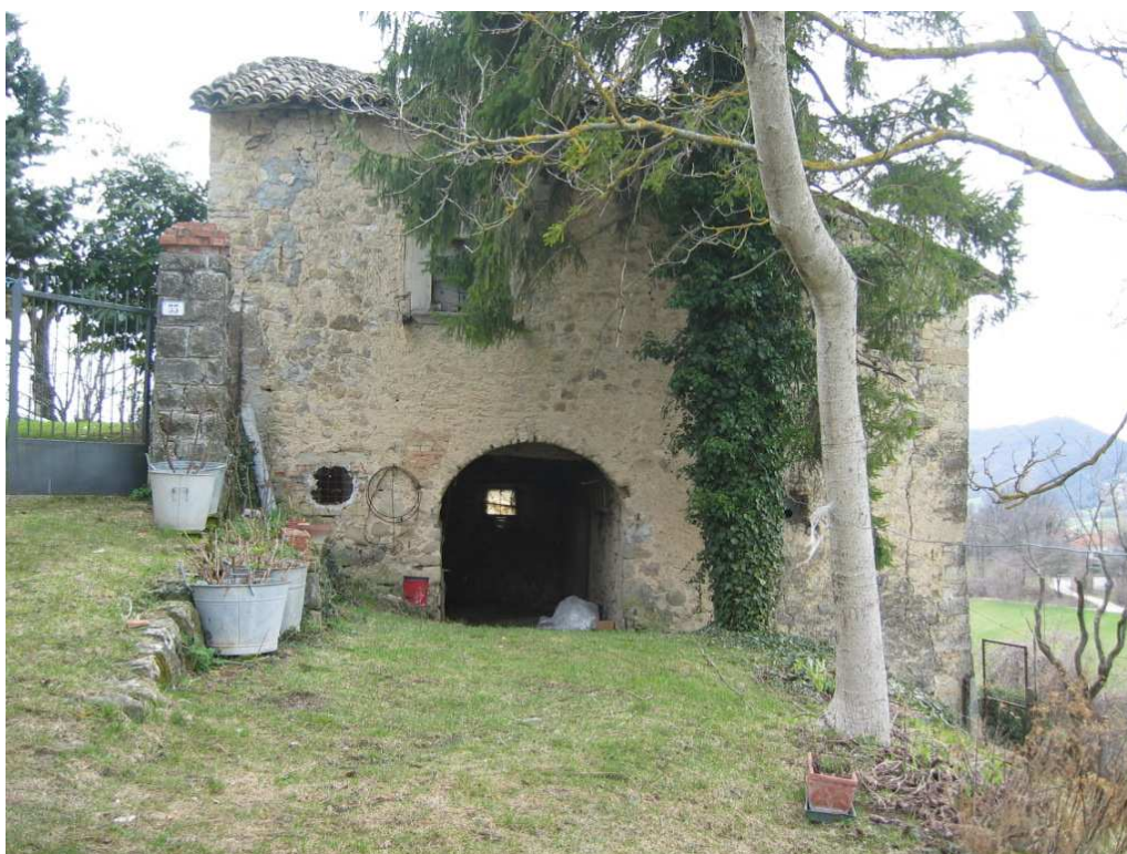
Foto n. 12: Miralago. Edificio rurale del XV sec.
