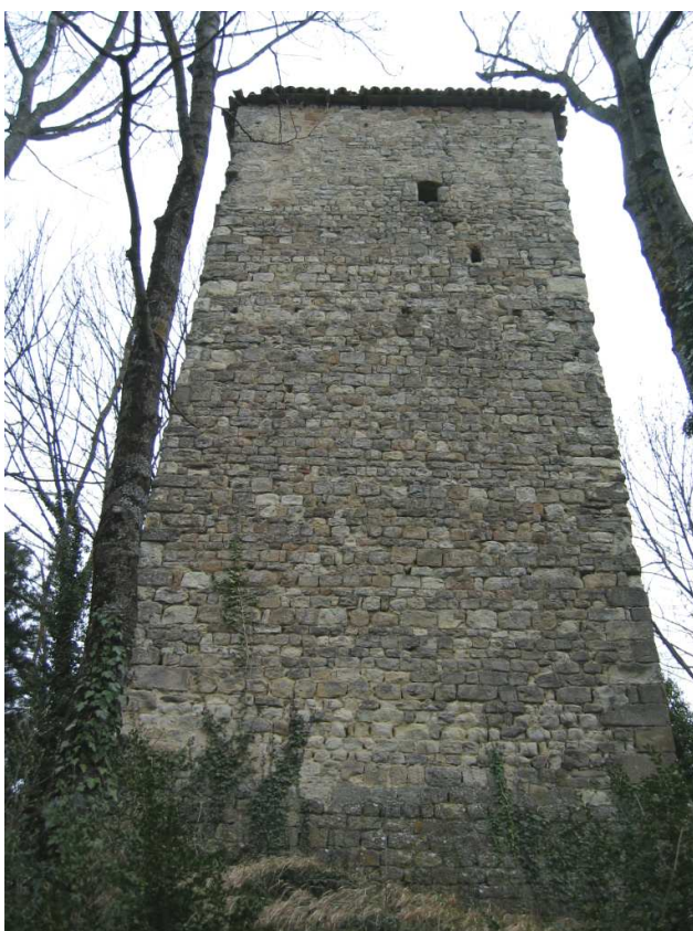
Foto n. 72: Torricella. La torre
