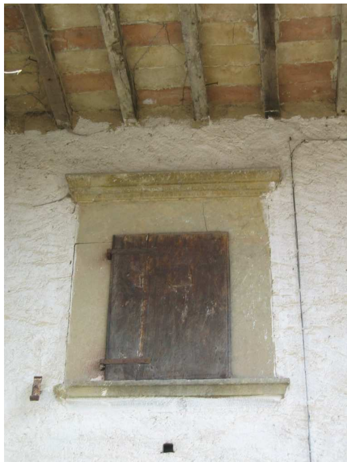
Foto n. 29: Il Casino. Casa a balchio, finestra rinascimentale
