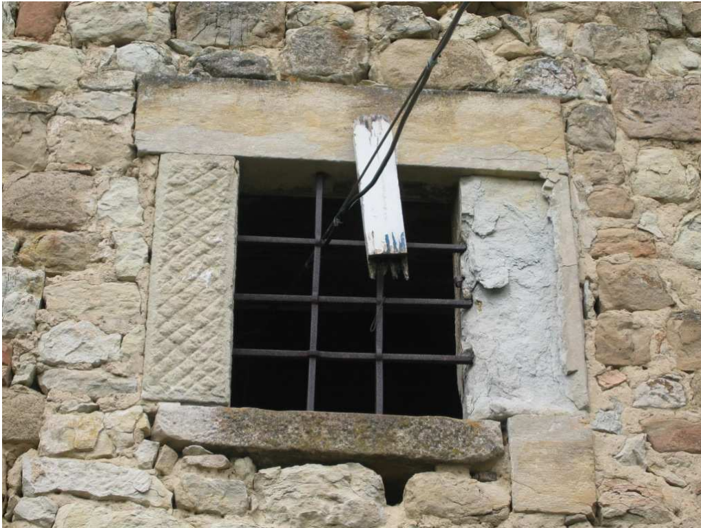
Foto n. 66: Torricella. Una finestra della torre
