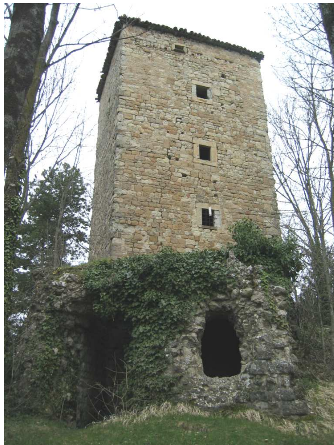
Foto n. 65: Torricella. Torre. Lato sud con cisterna
