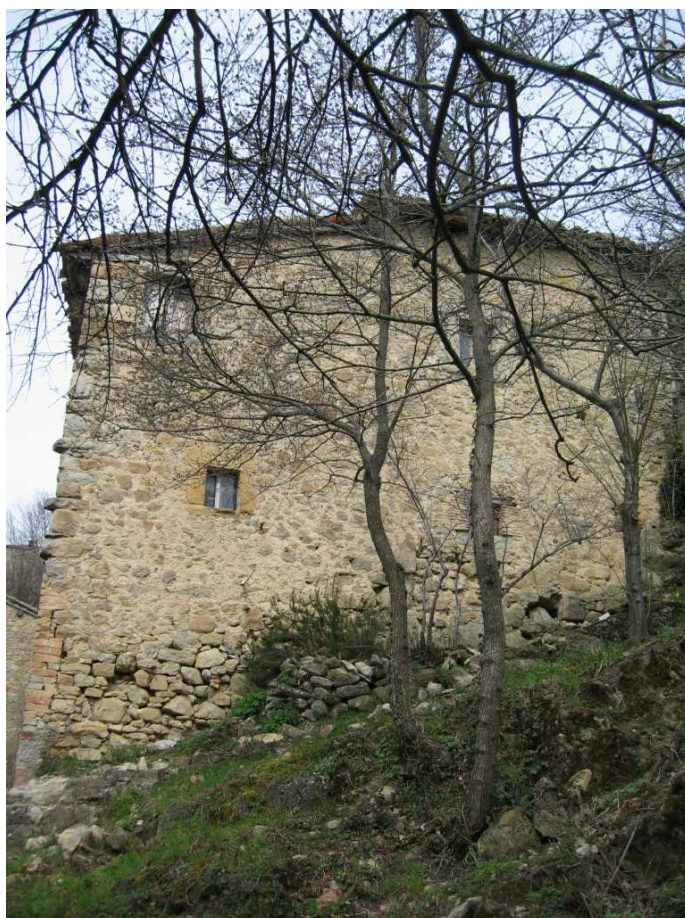
Foto n. 19: Miralago. Edificio rurale del XV sec
