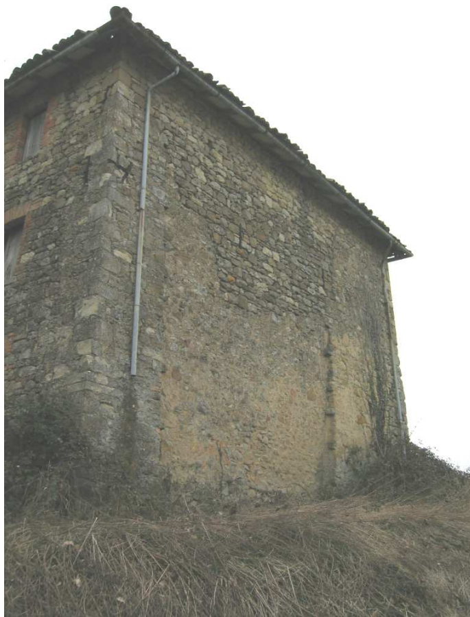
Foto n. 76: Torricella. Edificio in prossimità della torre
