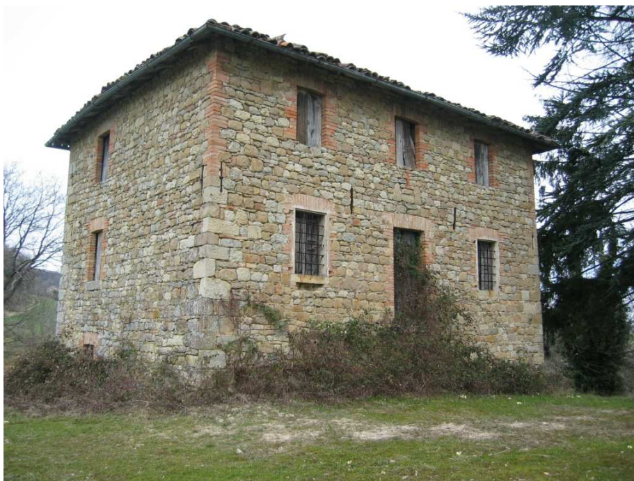
Foto n. 77: Torricella. Edificio in prossimità della torre
