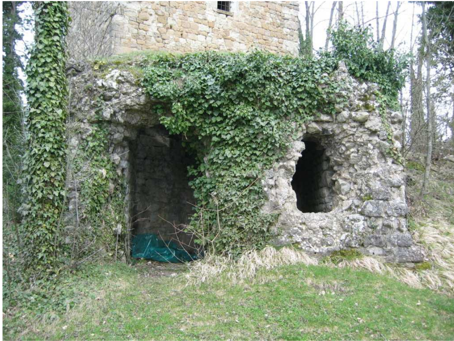
Foto n. 74: Torricella. Cisterna ai piedi della torre
