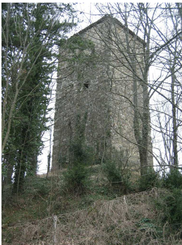
Foto n. 71: Torricella. La torre
