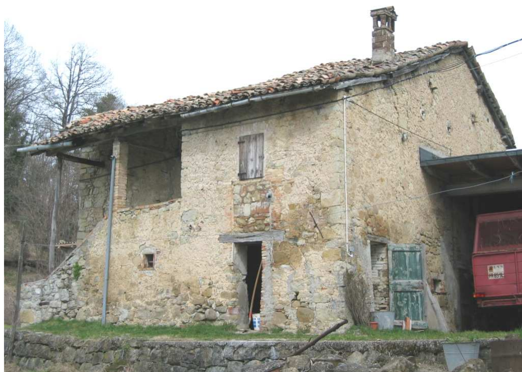
Foto n. 21: Miralago. Casa a balchio porticato.
