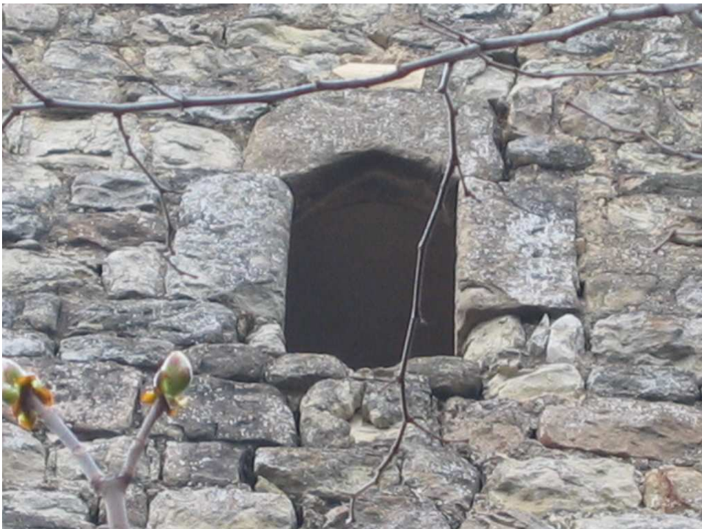
Foto n. 67: Torricella. Finestra all'ultimo piano della torre
