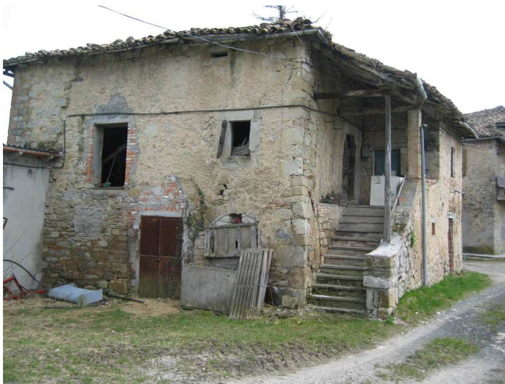
Foto n. 13: Miralago. Casa a balchio porticato.
